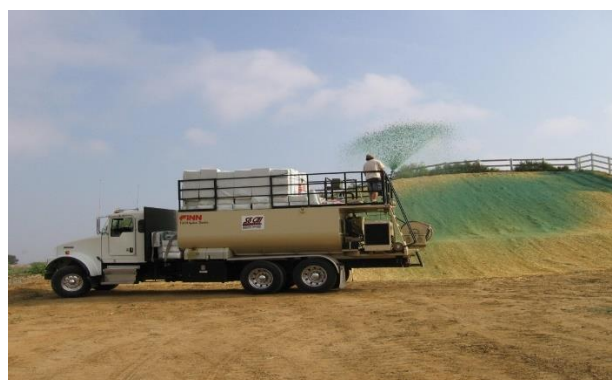
شکل ۱۷. استقرار پوشش‌های مصنوعی از نوع مالچ پلیمری برای کنترل فرسایش بادی [33]
