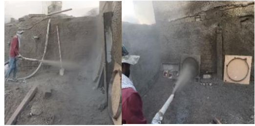
شکل ۴. نمونه‌ای از روش تهیه نمونه آزمایشی
