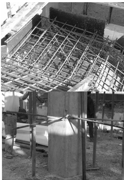
شکل ۸: گذاشتن میلگرد انتظار در کنج ستون برای ایجاد اتصال مفصلی
