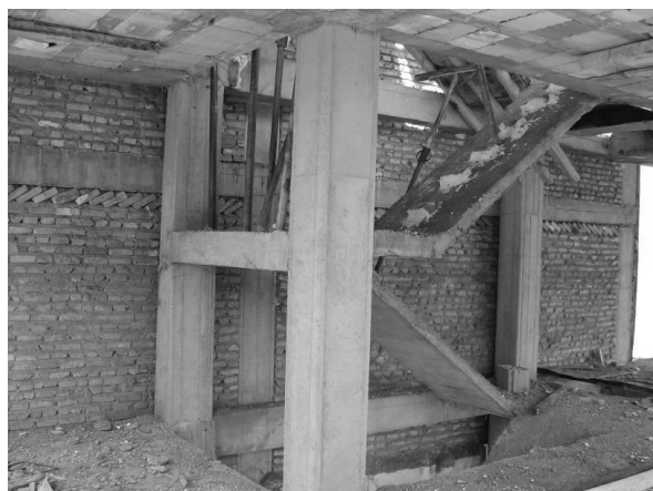
شکل ۲: برش مقطع پله دو طرفه دال بتنی
