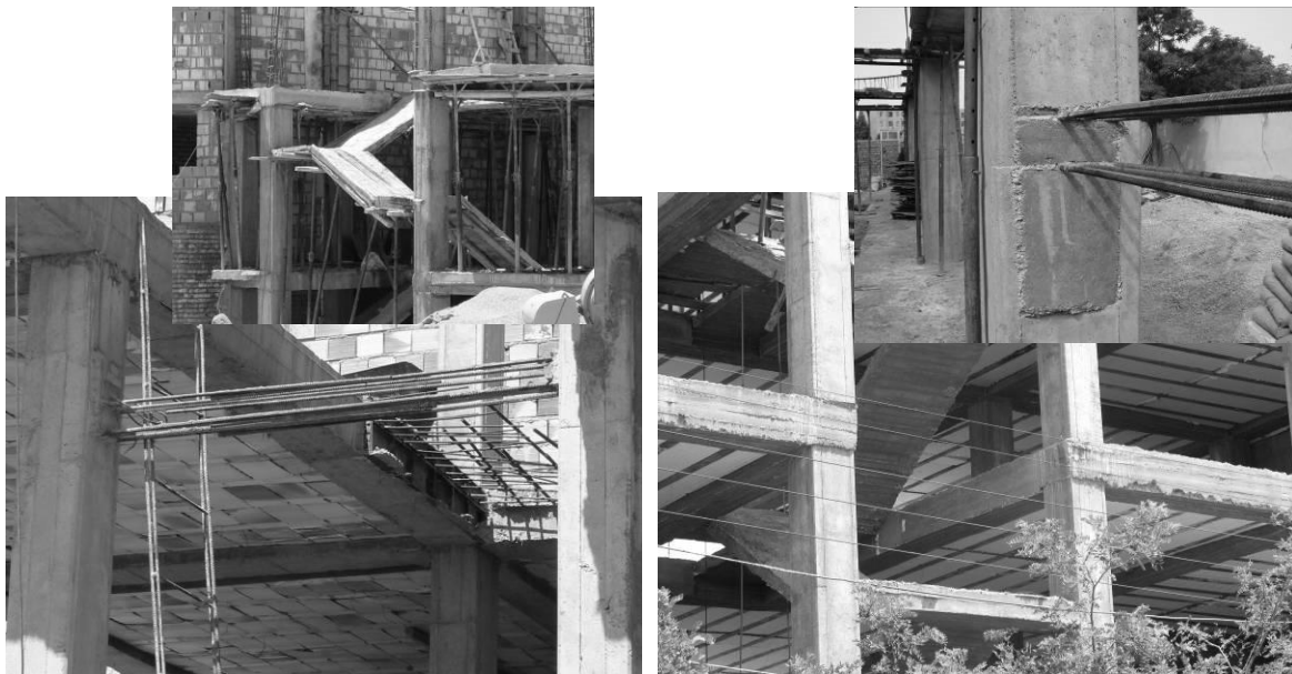
شکل ۵: کاهش ارتفاع تیر میان طبقه به اندازه ضخامت دال پله چگونگی میلگردگذاری و اجرا
