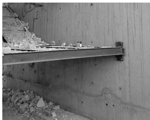
شکل ۷: نحوه اتصال تیرآهن به ستون یا دیوار بتنی؛ سمت راست (تعبیه ورق نشیمن)، سمت چپ (تعبیه رول بولت)
