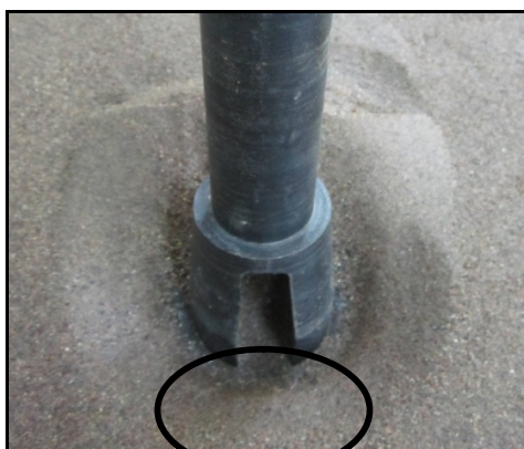
شکل (۱۲) تشدید فرسایش بستر در لبه‌های شکاف
