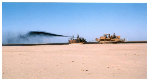
شکل ۱۶. استقرار پوشش‌های مصنوعی از نوع مالچ نفتی برای کنترل فرسایش بادی [33]
