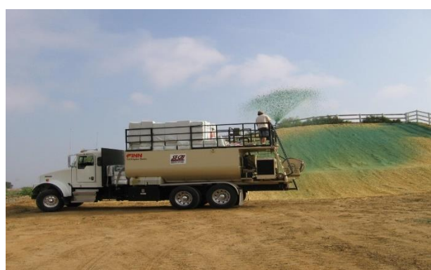
شکل ۱۷. استقرار پوشش‌های مصنوعی از نوع مالچ پلیمری برای کنترل فرسایش بادی [33]
