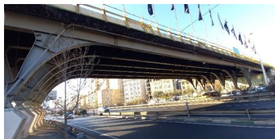
شکل ۳. تصویر واقعی پل
