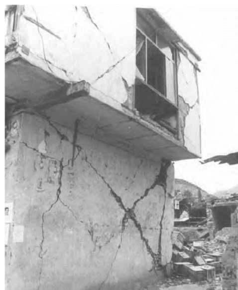
شکل ۱. نمونه عملکرد میانقاب در زلزله رودبار منجیل [5]
