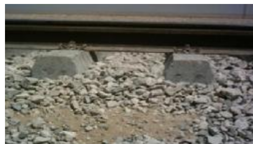
شکل 2 صلبیت لایه بالاست در محور اهواز - بندر امام
