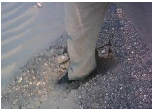
شکل 4 کاهش مقاومت بستر و نفوذ پا در شانه زیرسازی
