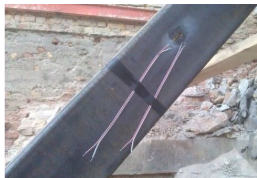
شکل (۷) نمونه کرنش‌سنج‌های نصب شده روی بدنه‌ی تیرک
