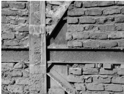
شکل (۱) اتصال مهاربندی هم‌مرکز
