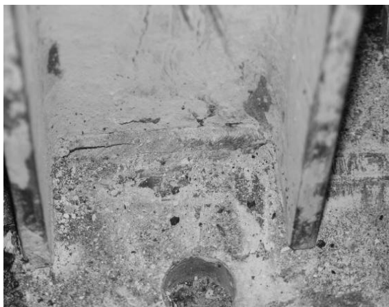
شکل (۹) نمایی از ترک‌خوردگی پای ستون بعد از آزمایش
