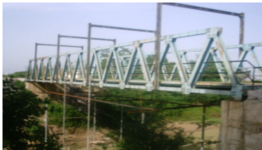
شکل ۴ پل خریایی نکا
