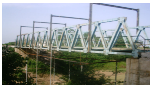
شکل ۴ پل خریایی نکا
