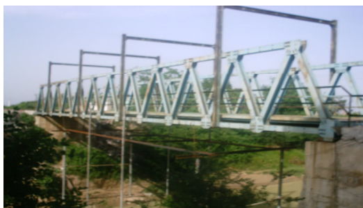
شکل ۴ پل خریایی نکا
