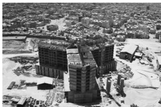
شکل (۱) نمای از بالای برج در حال ساخت
