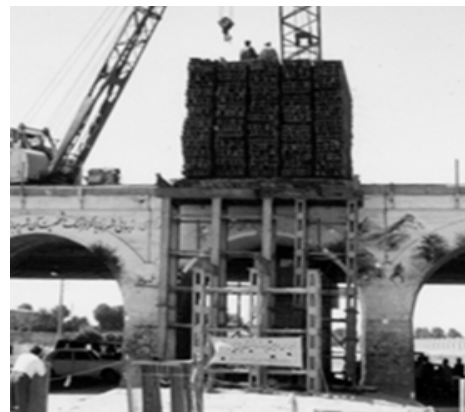
شکل (۲) بارگذاری استاتیکی پل اکبرآباد
