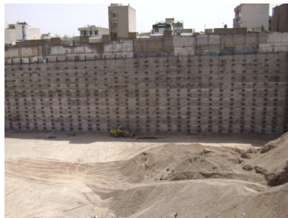
شکل (۳) اجرای سیستم حفاظت دیواره‌های گود با روش دیوار برلنی (عمق گود ۲۴ متر) [۸]
