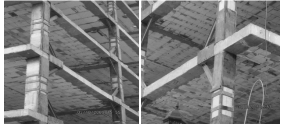
شکل (۱) کاربرد عملی مقاوم سازی قاب بتن آرمه با دستک و طوقه فلزی
