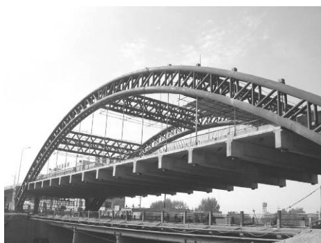
شکل (۱) پل قوسی بی‌چوآن
