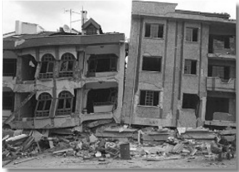
شکل (۱) برخورد دو ساختمان در زلزله مکزیکوسیتی ۱۹۸۵
